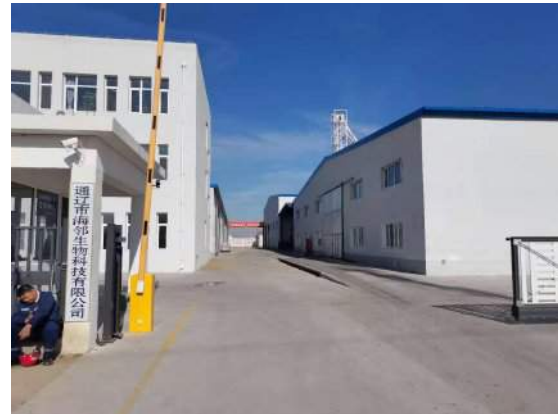
厂区道路平整
